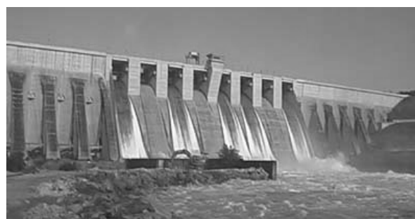
Fig. 3 – La diga di Manantali (1988), situata in Mali sul maggiore affluente del Senegal (il Bafing), trattiene le acque piovane a monte, costituendo una riserva di 12 miliardi di m 3 d'acqua (foto: www.omvs-soe.org)
