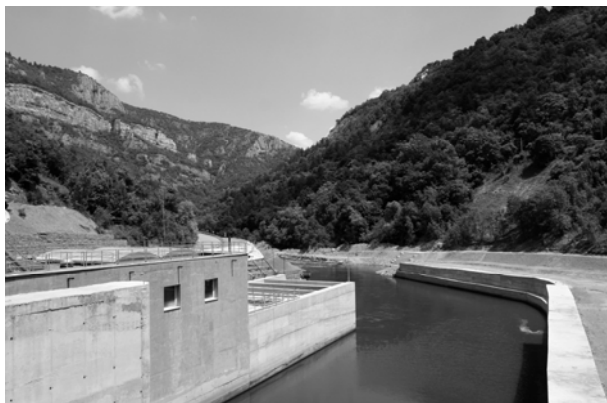
Fig. 10 – Impianto di produzione di energia idroelettrica a Svoge (foto: Biolo E., 2008).
